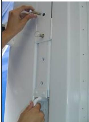
Al mover el techo para trabajar en una altura diferente, posicione los apoyos, localizados en las columnas de los paneles, coloque los tornillos, conforme la figura.
